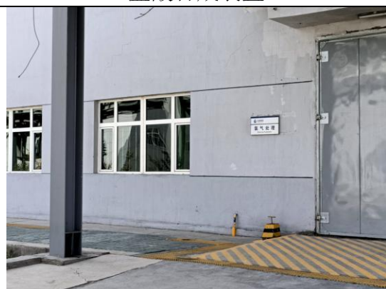
氯气处理车间
