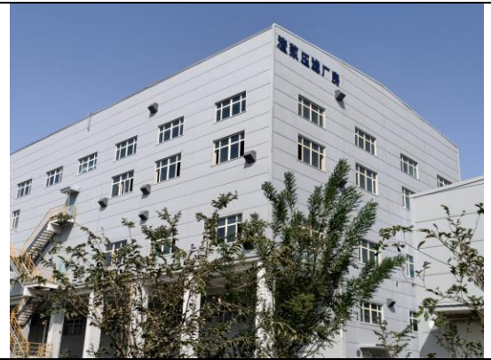
渣浆压滤厂房
